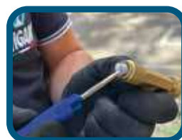
Extracción de junta
